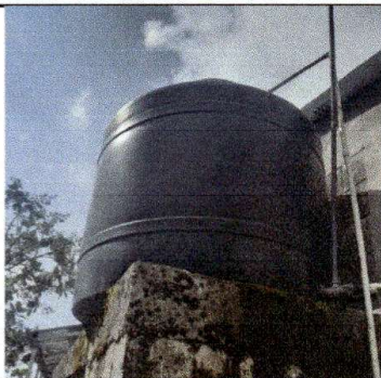
Foto 1: Sustrucción de depósito de agua
