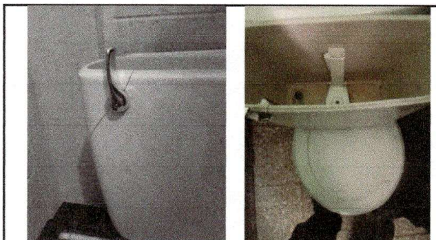
Foto 3: Sustrucción de inodoros
